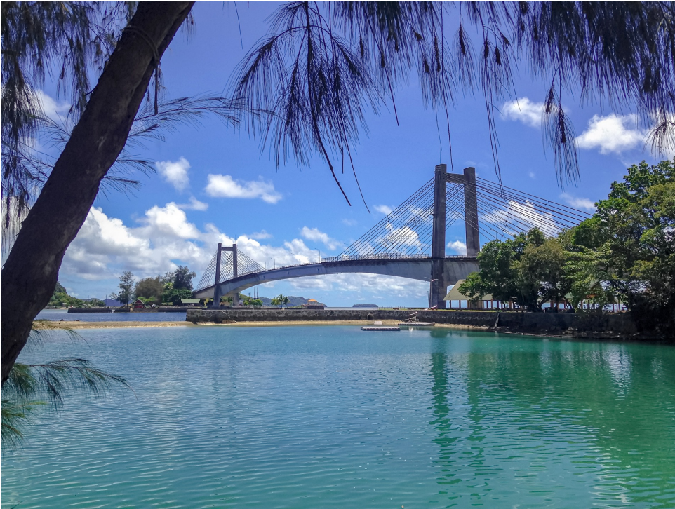
日本パラオ友好の橋 (アイライ州内)
